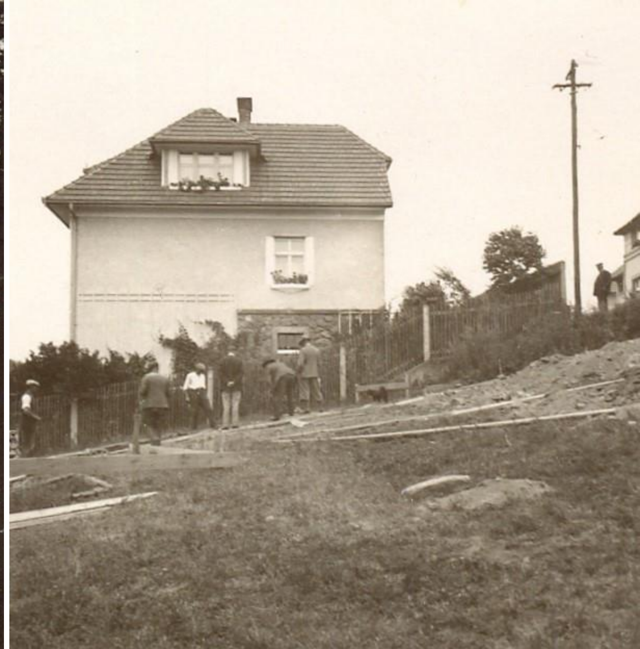
První práce – vytyčování opěry a pilířů mostu
