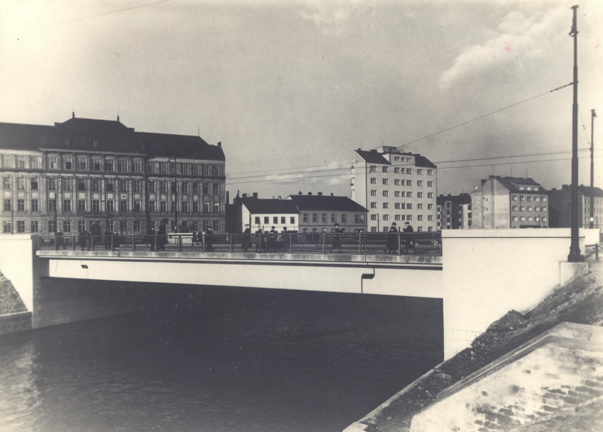
Most přes Svratku v Brně
