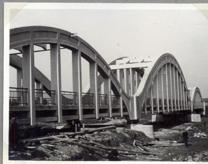
CELKOVÝ POHLED NA MOST
