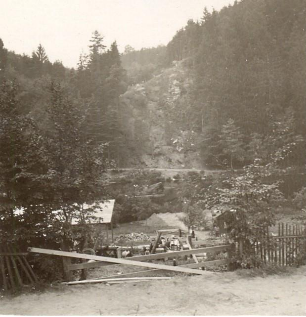
Zahájení stavby - pohled směr Bechyně
