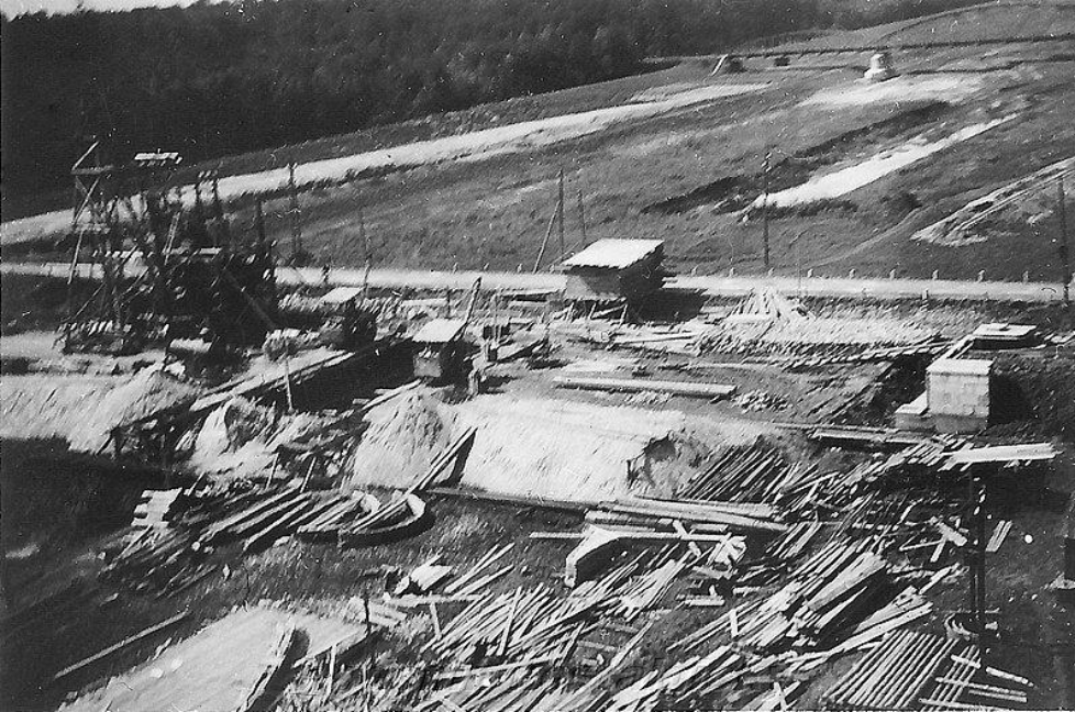
Zahájení stavby – duben 1933 Uvedení do provozu – 5.11.1934
