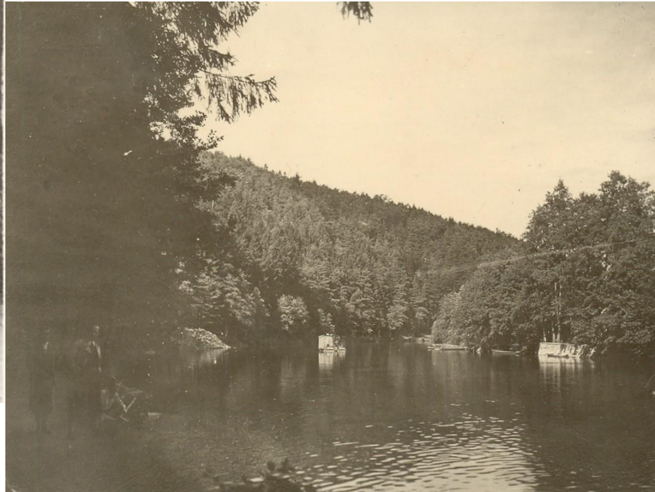
Zahájení stavby – pohled proti vodě
