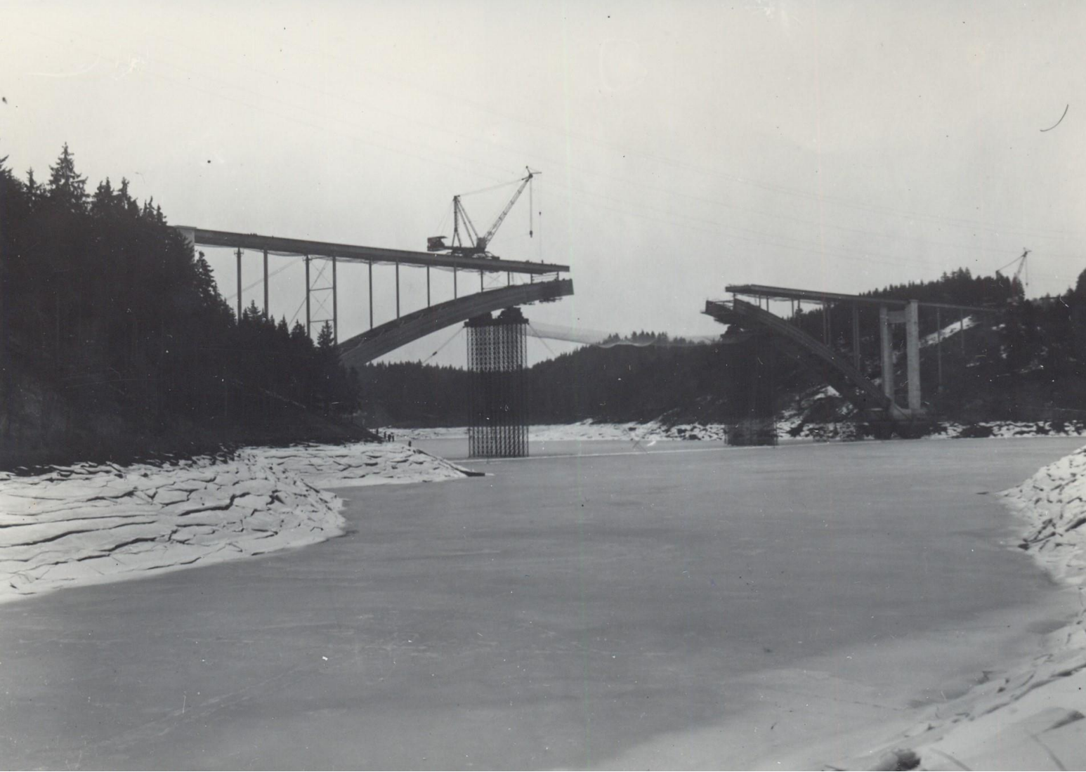
Ocel oblouku – Vítkovice, ocel trámy a stojky – Lískovec Železobetonové pilíře, železobetonová deska, vozovka – SSŽ Montáž ocelových částí – Hutní montáže Ostrava
