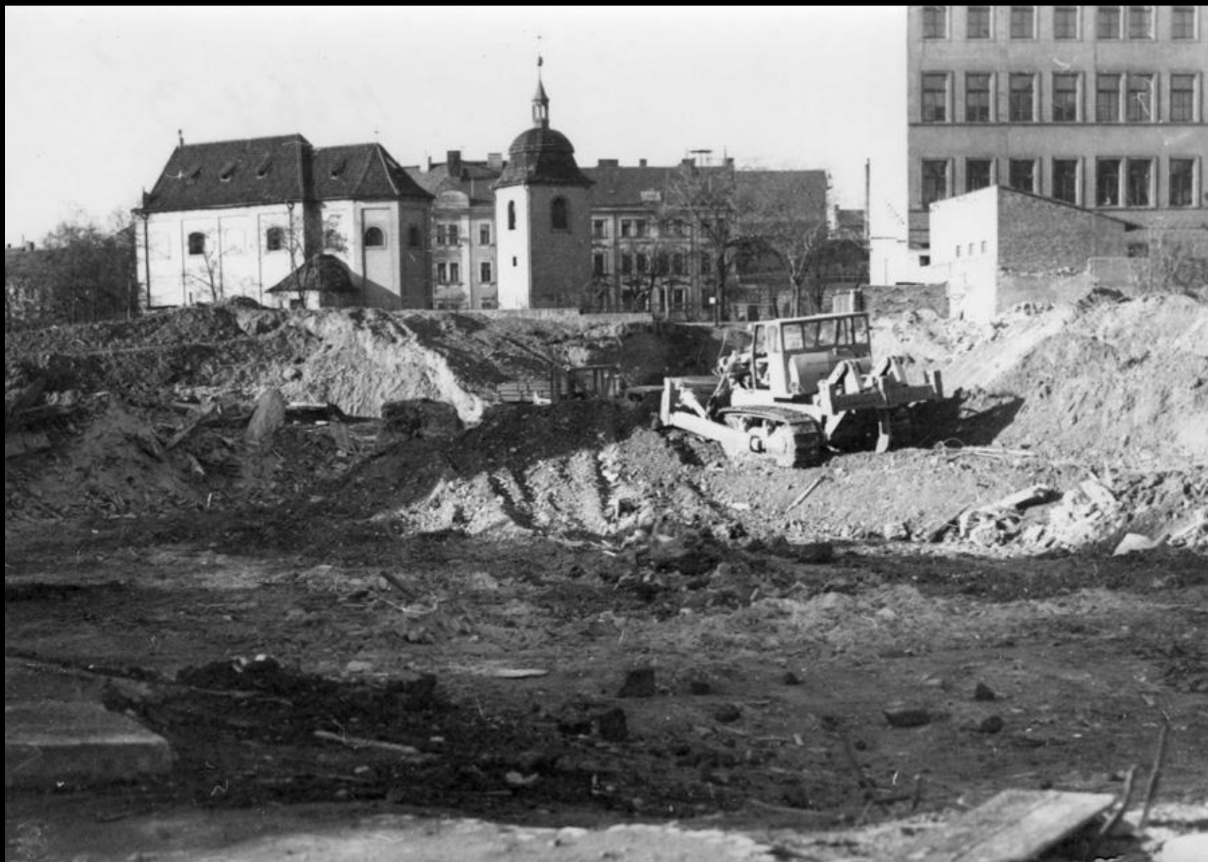
Stavba stanice Pražského povstání
