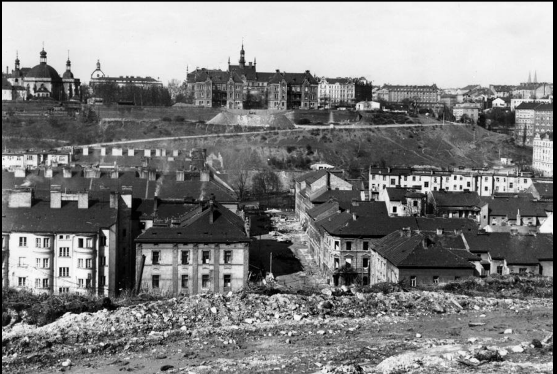
Stavba Nuselského mostu
