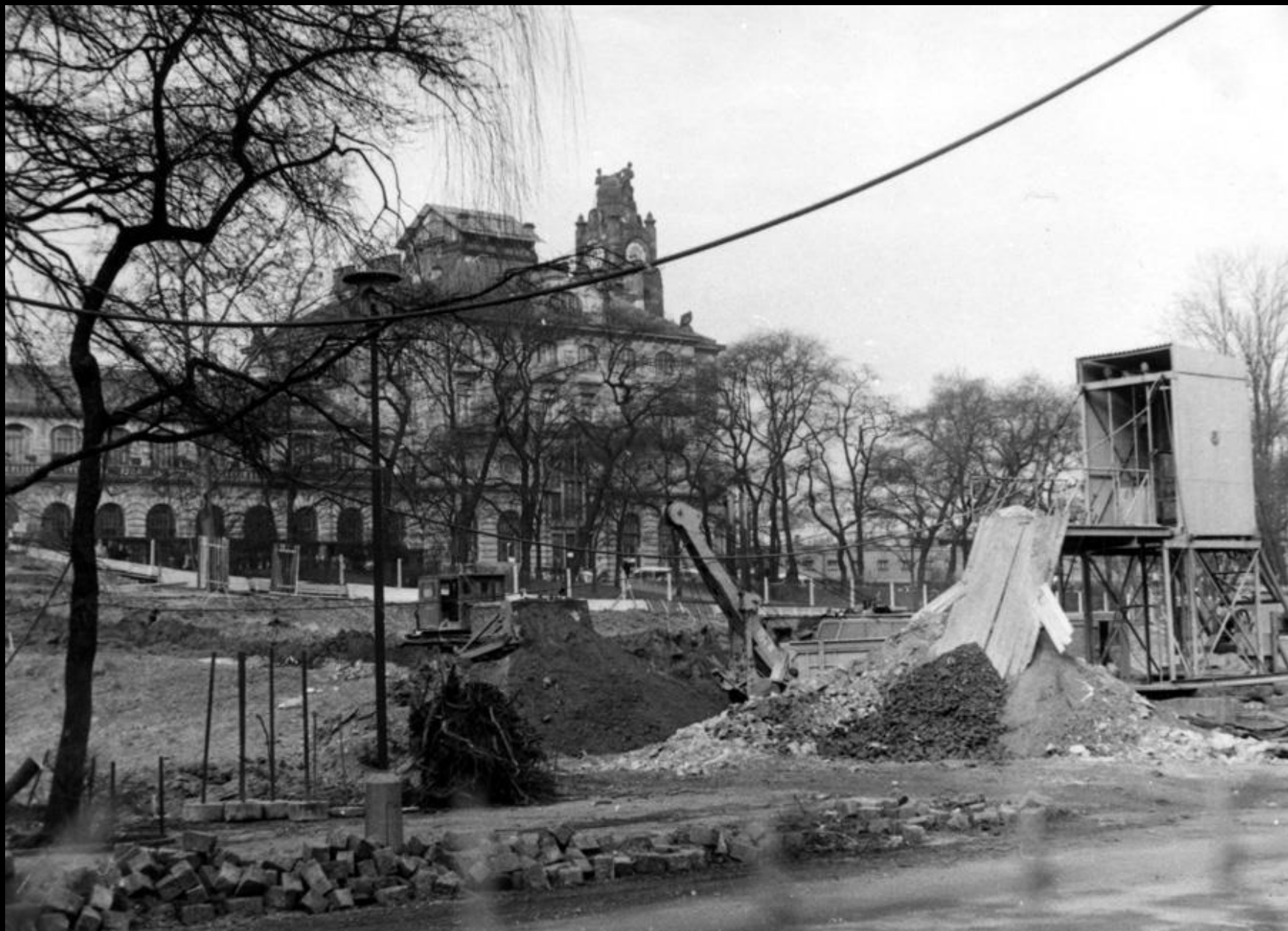
15. 3. 1967 zahájení stavby stanice Hlavní nádraží
