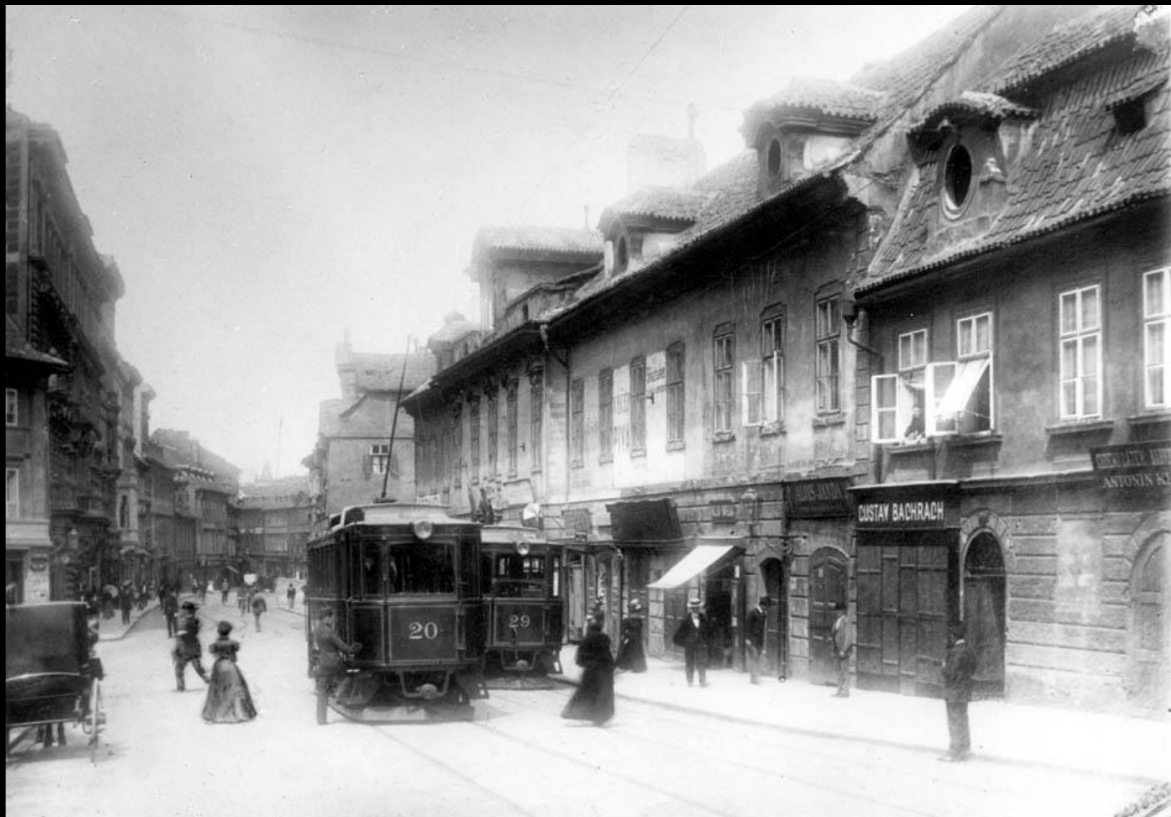
1898 Výstavba novoměstských tratí
