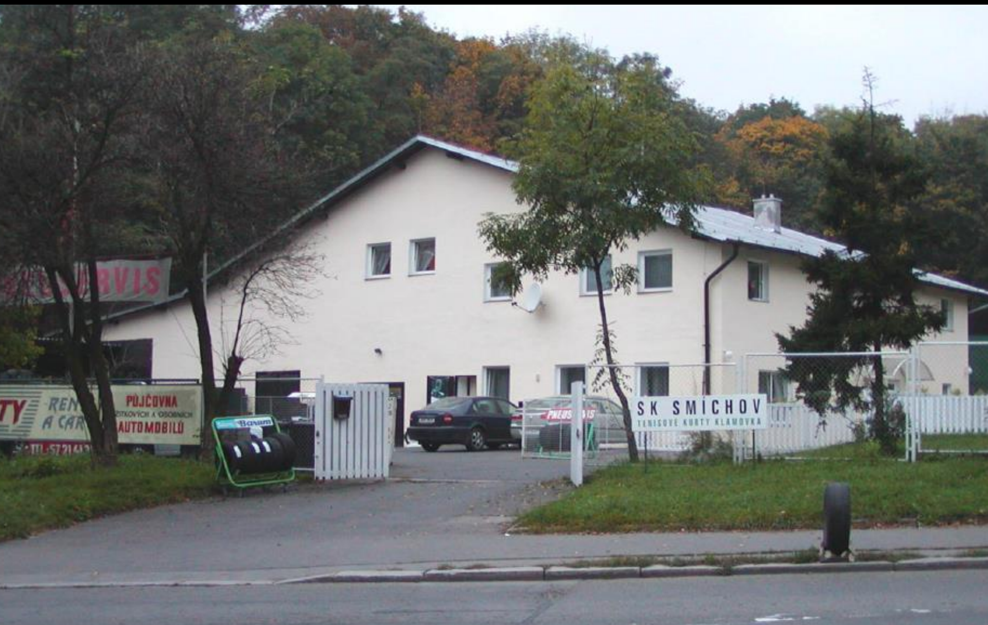
Elektrárna na Klamovce
