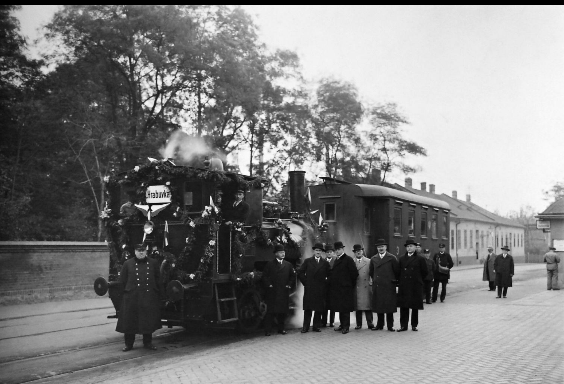
5. 10. 1930 „Místní dráha Mariánské Hory – Brušperk“
