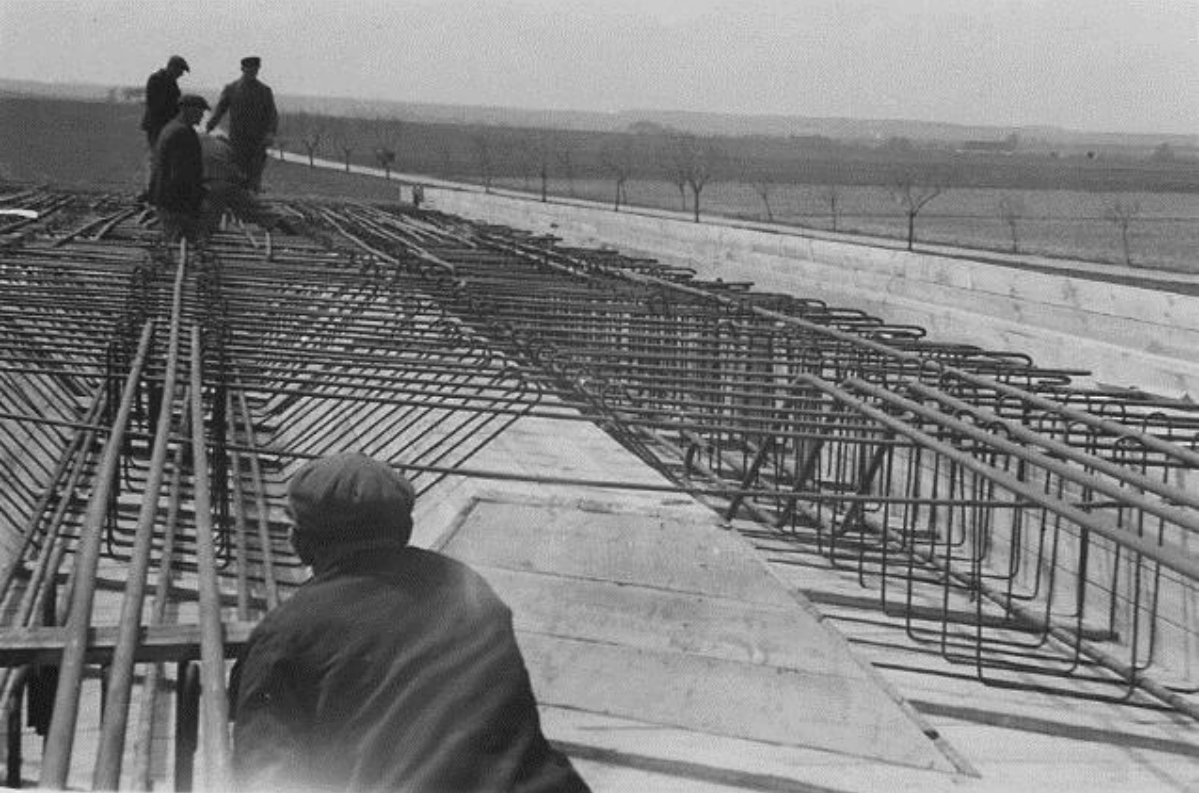
Stavba mostu přes dálnici. Silnice z Čestlic do Dobřejovic
