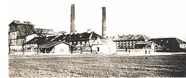
Cukrová rafinerie Hrušovany 1931
